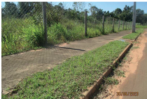
Figura 74: Calçada na Rua Giuseppe Leggi. Fonte: Master Ambiental, 2023.
