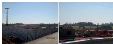
Figura 36: Empreendimento residencial em processo de implantação na AID. Fonte: Master Ambiental, 2023.
