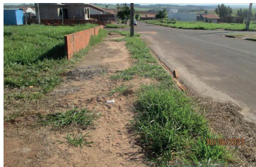
Figura 76: Calçada com obstrução na Rua Elizaete Alves. Fonte: Master Ambiental, 2023.
