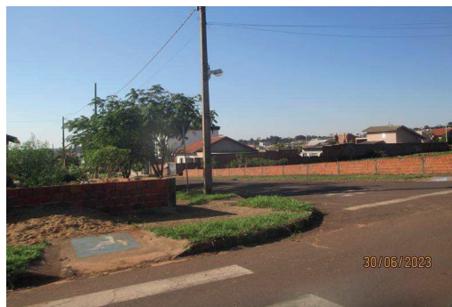
Figura 77: Calçada com obstrução na Rua Olavo Bilac. Fonte: Master Ambiental, 2023.
