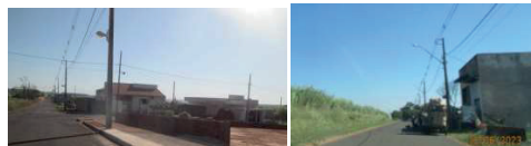
Figura 46: Iluminação na AID. Fonte: Master Ambiental, 2023.
