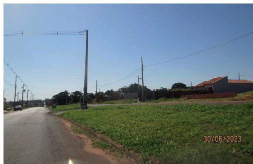
Figura 75: Calçada inexistente na Avenida Europa. Fonte: Master Ambiental, 2023.
