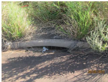
Figura 48: Boca de lobo na Rua Pablo Picasso. Fonte: Master Ambiental (2023).
