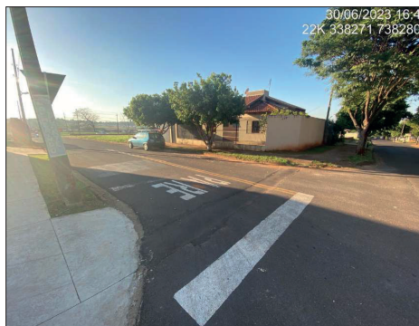
Foto 14 - Sinalização horizontal na Travessa Almerindo Duarte em boas condições
