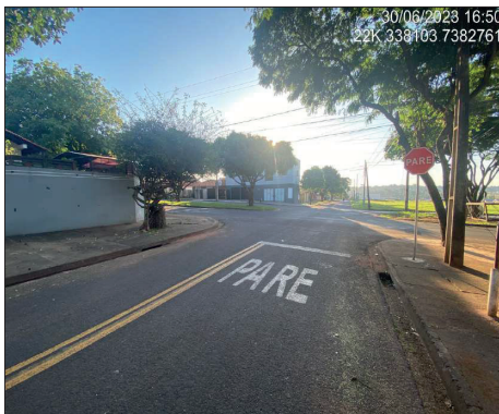
Foto 11 - Sinalização vertical e horizontal em boas condições (Rua Ponta Grossa x Av. Ceará)
