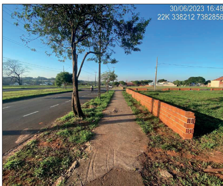
Foto 17 - Calçada do entorno do futuro empreendimento (Av. Ceará)
