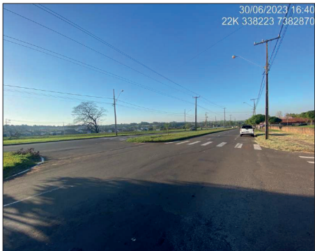
Foto 16 - Pavimentação asfáltica da Av. Ceará
