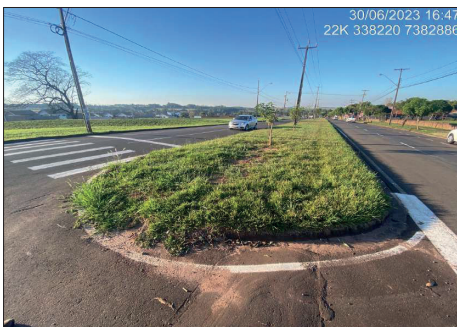
Foto 12 - Sinalização horizontal em frente ao futuro empreendimento sem acessibilidade no canteiro central (Av. Ceará)
