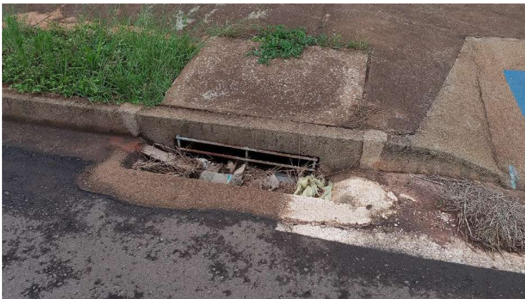
Figura 19: Boca de lobo existente no bairro consolidado dentro do perímetro urbano.
