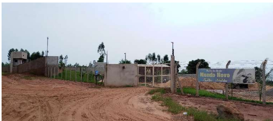
Figura 11: Porto de areia, lote vizinho ao lote do empreendimento. Fonte: Master Ambiental.
