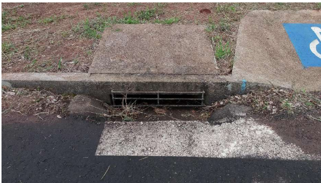
Figura 20: Boca de lobo existente no bairro consolidado dentro do perímetro urbano.
