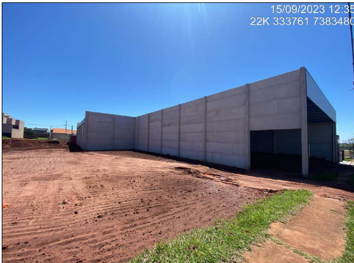
Foto 1 – Área do Empreendimento (infraestrutura já existente)
