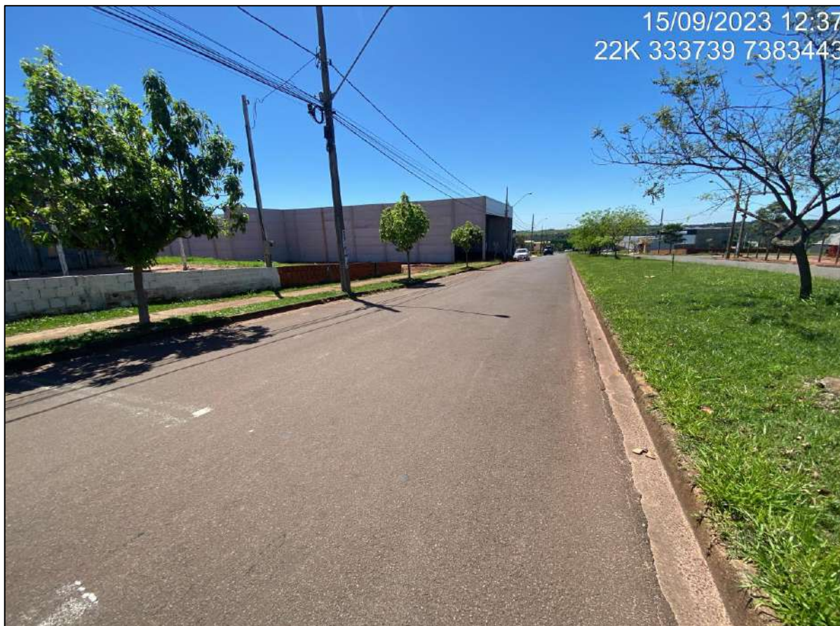
Foto 22 – Pavimentação asfáltica da Av. Ilha do Mel
