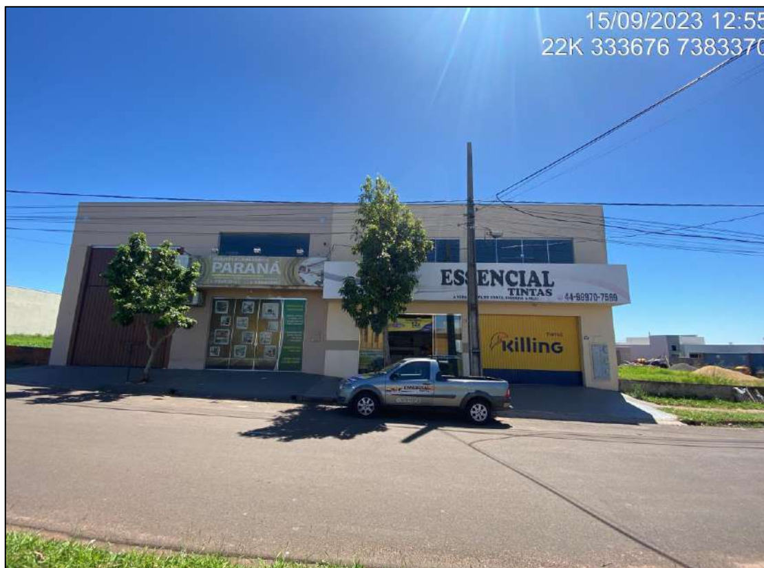
Foto 11 - Empresa de Móveis Planejados e Loja de Tintas presentes na AID a 160 metros do futuro empreendimento (Av. Ilha do Mel, 1101, Cianorte-PR, CEP 87023-390 e Av. Ilha do Mel, 1091 , Cianorte-PR, CEP 87023-390 respectivamente)
