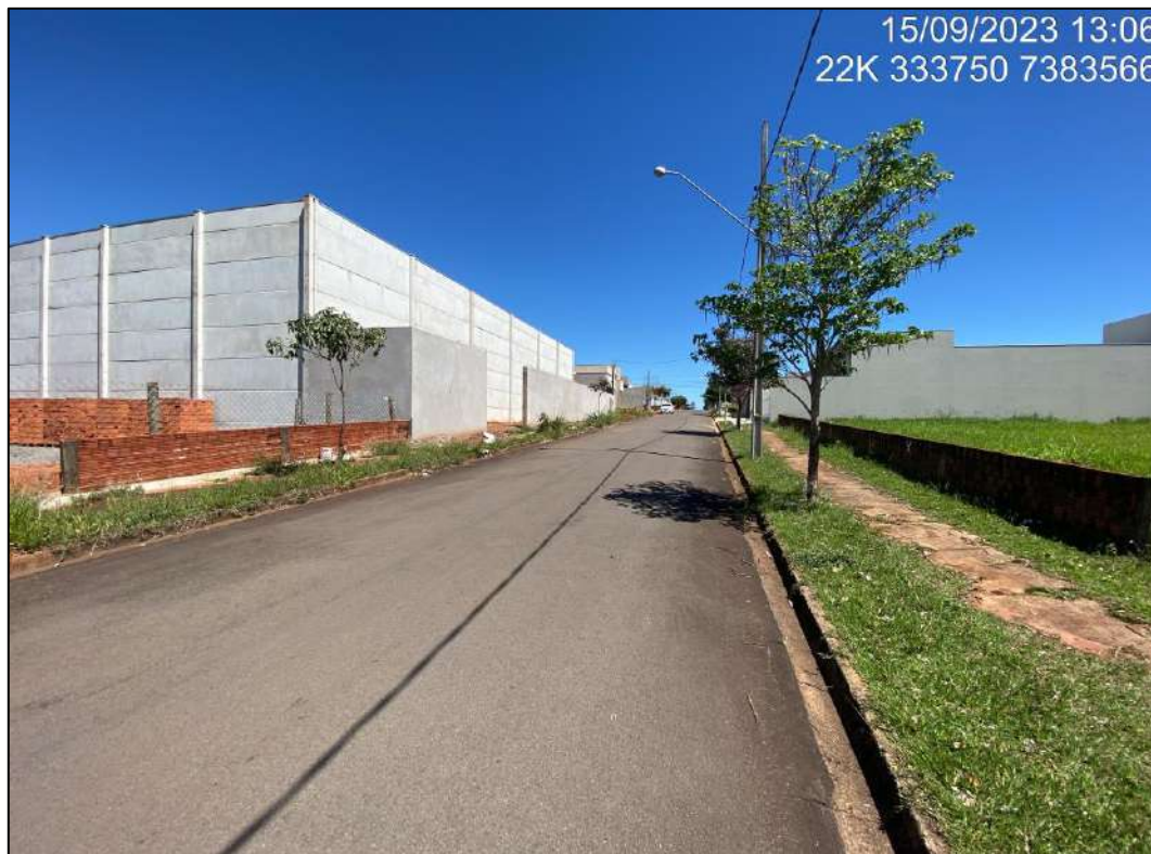
Foto 28 - Situação asfáltica na Rua Barcelona
