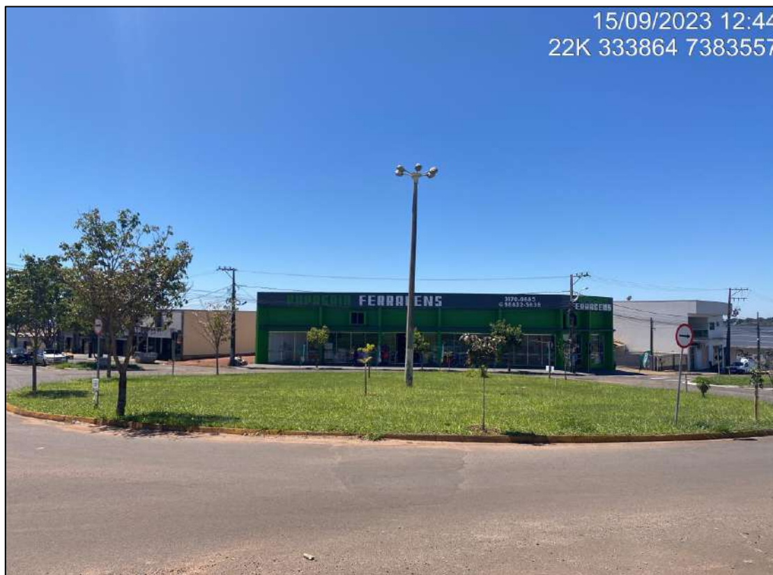
Foto 8 - Loja de Ferragens presente na AID a 180 metros do futuro empreendimento (Av. América, 654, Cianorte-PR, CEP 87200-000)
