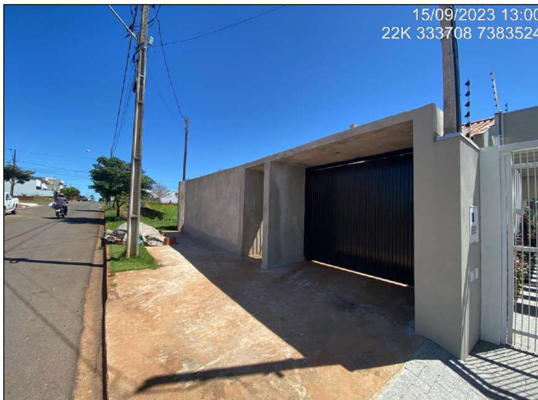
Foto 14 - Residência presente na AID a 100 metros do futuro empreendimento (Rua Barcelona, S/N, Cianorte-PR, CEP 87200-000)
