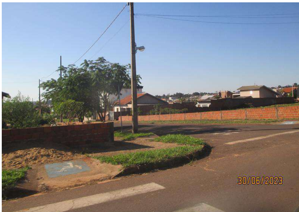
Figura 66: Calçada com obstrução na Rua Olavo Bilac. Fonte: Master Ambiental, 2023.
