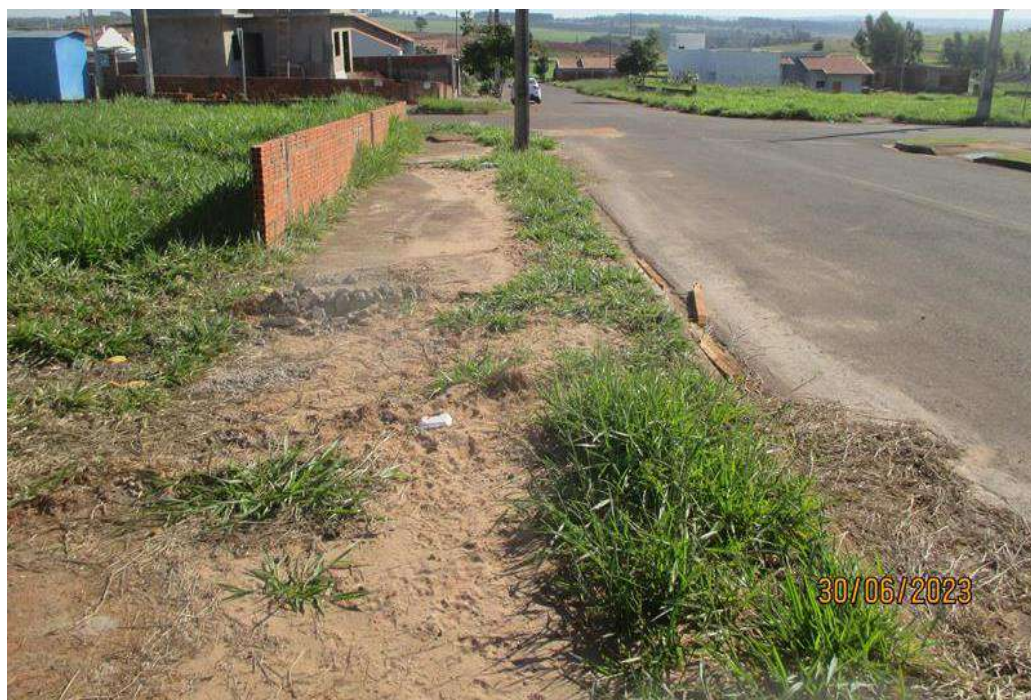
Figura 65: Calçada com obstrução na Rua Elizaete Alves. Fonte: Master Ambiental, 2023.
