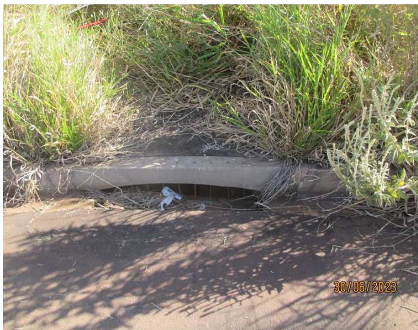
Figura 37: Boca de lobo na Rua Pablo Picasso. Fonte: Master Ambiental (2023).
