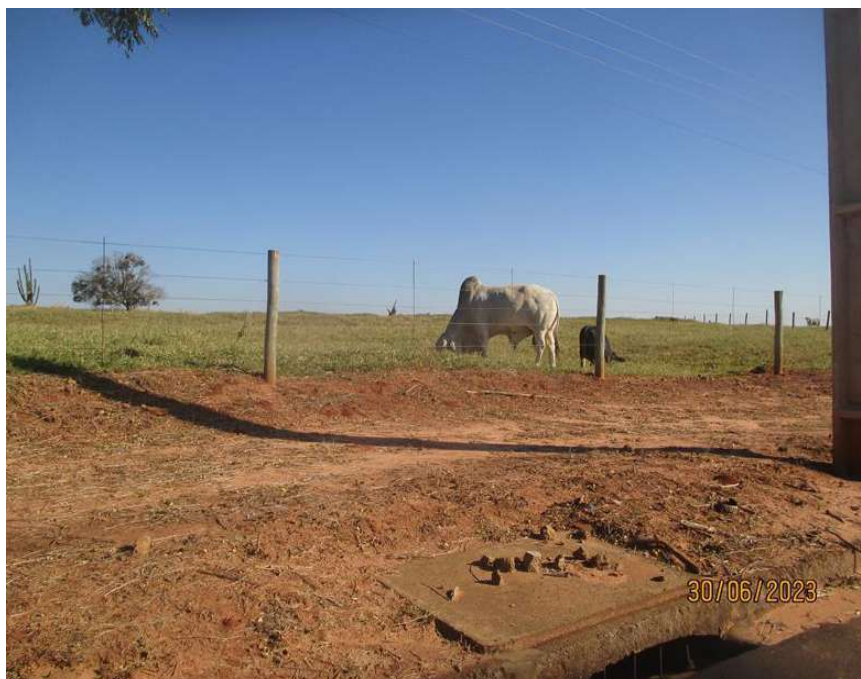
Figura 36: Boca de lobo na Rua Olavo Bilac. Fonte: Master Ambiental (2023).
