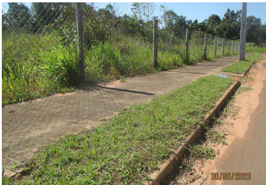
Figura 63: Calçada na Rua Giuseppe Leggi. Fonte: Master Ambiental, 2023.
