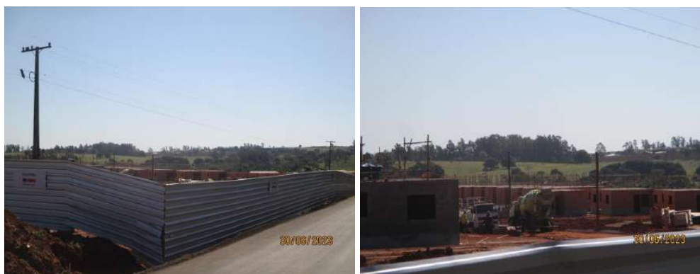
Figura 25: Empreendimento residencial em processo de implantação na AID. Fonte: Master Ambiental, 2023.
